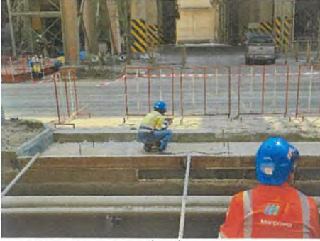
1.งานเจาะคอนกรีตเสียบเหล็ก Dowel (เซ็นเตอร์ไลน์)
