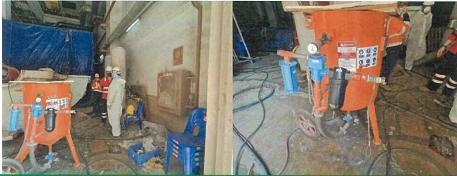
ผู้ปฏิบัติงานมีการจัดเตรียมสิ่งนิรภัยสำหรับป้องกันการหลุดกระเด็นของท่อแรงดันลม
