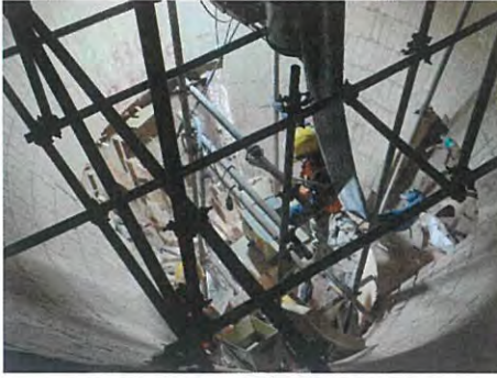
7.งานเข้าแบบเตรียมเท Castable กรวย W2C53 (นั้สตร)
