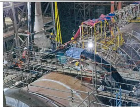
8. งานซ่อมแก้ไข Spring plate ของ Girth gear (เอสพีแกงค์คอย)
