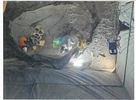
3. งานเก็บ Glass beads หลังทำ Sand blast (เจเอชเอ็ม คอนโทรลล์)
