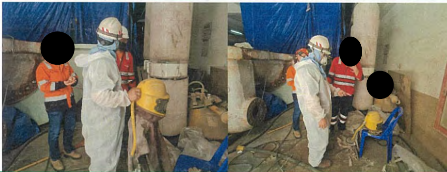
ผู้ปฏิบัติงานมีการจัดเตรียมและใช้อุปกรณ์ช่วยหายใจและท่อลมสำหรับการทำงาน Sand blast
