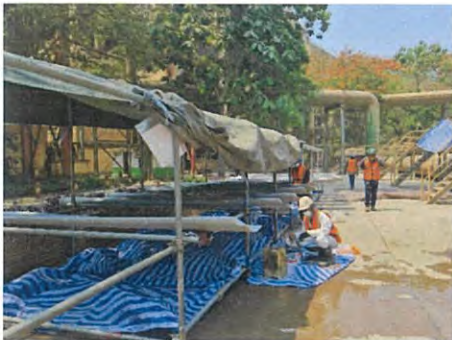
4.งานทาสีเคลือบใบพัดลม Cooling tower (ชินเนอริย์)
