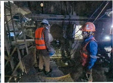
9. งานสกัดปูนผนัง Riser pipe (กวางทอง)
