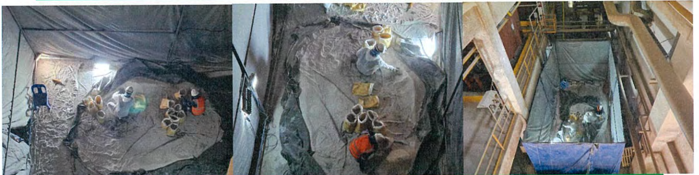
ผู้ปฏิบัติงานมีการจัดทำฉากกันเพื่อป้องกันการกระจายของวัสดุที่เกิดจากการทำงาน Sand blast
